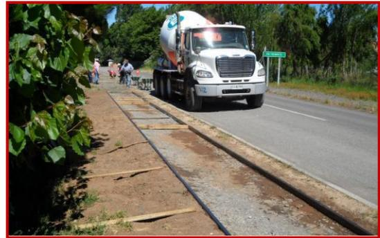
El proyecto contempló la construcción de veredas en ambos costados por la avenida de ingreso de la Localidad Chillancito, con una extensión de 4.060 metros y de 1,20 x 0.08 metros en hormigón premezclado.
