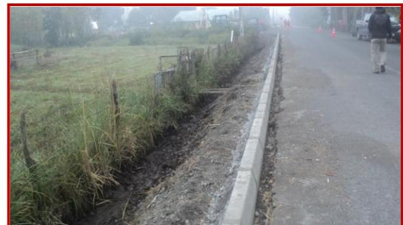
La obra consiste en la construcción de veredas en el Sector el Progreso, Comuna de Cabrero, la obra gruesa estará compuesta principalmente por la construcción de 1200 mts. Lineales de hormigón H-25 de 8cm. De espesor y el ancho será de 1,20 mts.-
